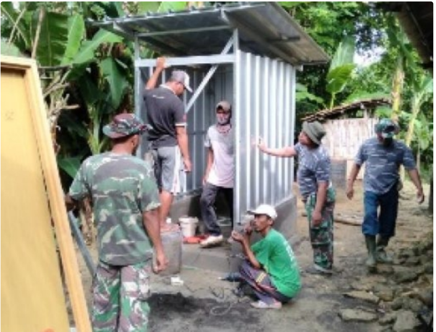
Pemasangan Galvalom Jamban milik Bapak Rosid warga Dusun Langdelem Desa Gangseyan Kecamatan Sepulu Kabupaten Bangkalan.
